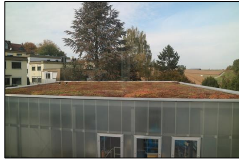
Gebäude mit Flachdach
