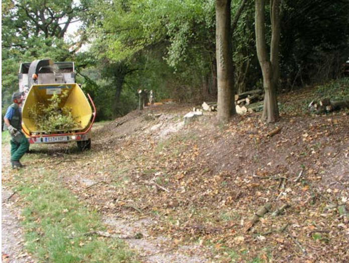
Beginn der Rodungsarbeiten, Oktober 2007
