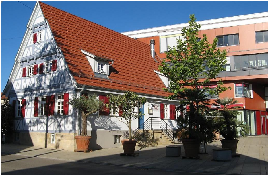
Hauptstraße 33 nach Sanierung
