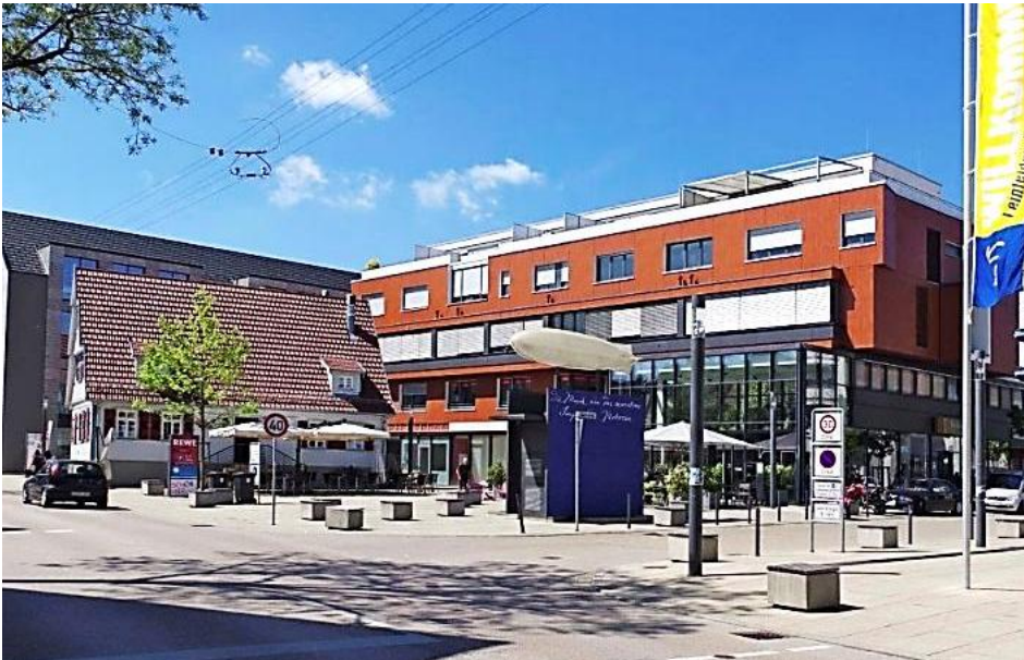
Ecke Hauptstraße/Kanalstraße „Zeppelin-Platz“ vor und nach Sanierung
