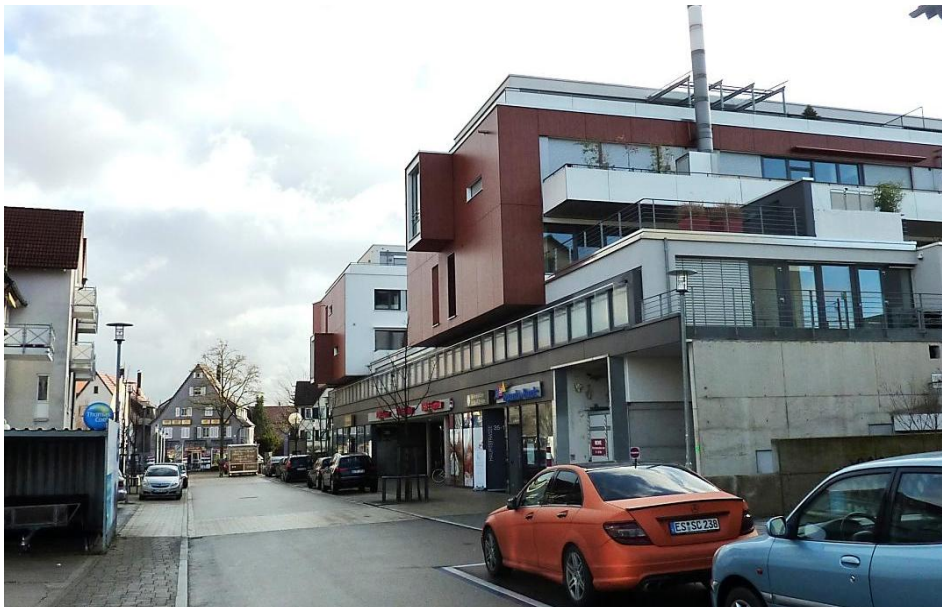
Kanalstraße nach Sanierung
