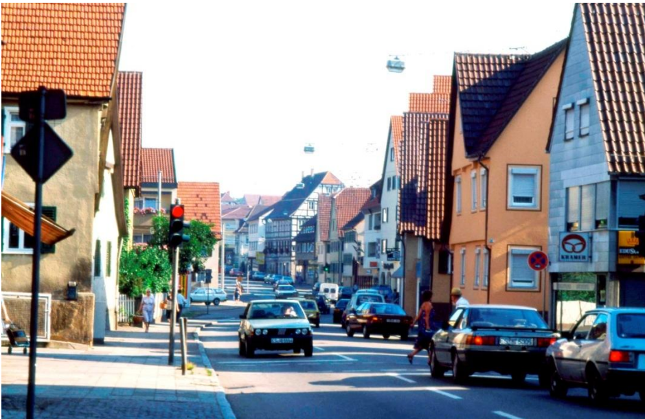
Hauptstraße 29-31 vor und nach der Sanierung
