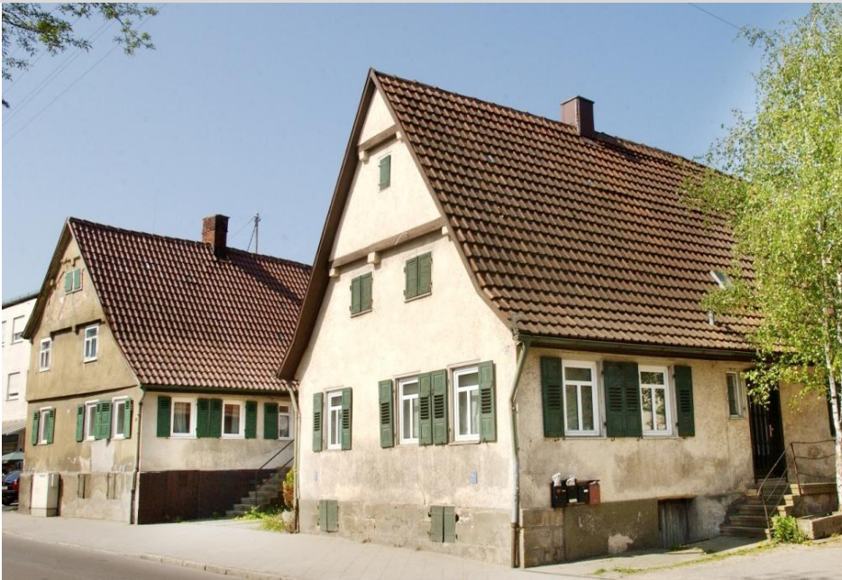
Hauptstraße 33 vor Sanierung
