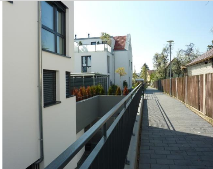
Hinterhofstraße/ Kapellenweg nach Sanierung
