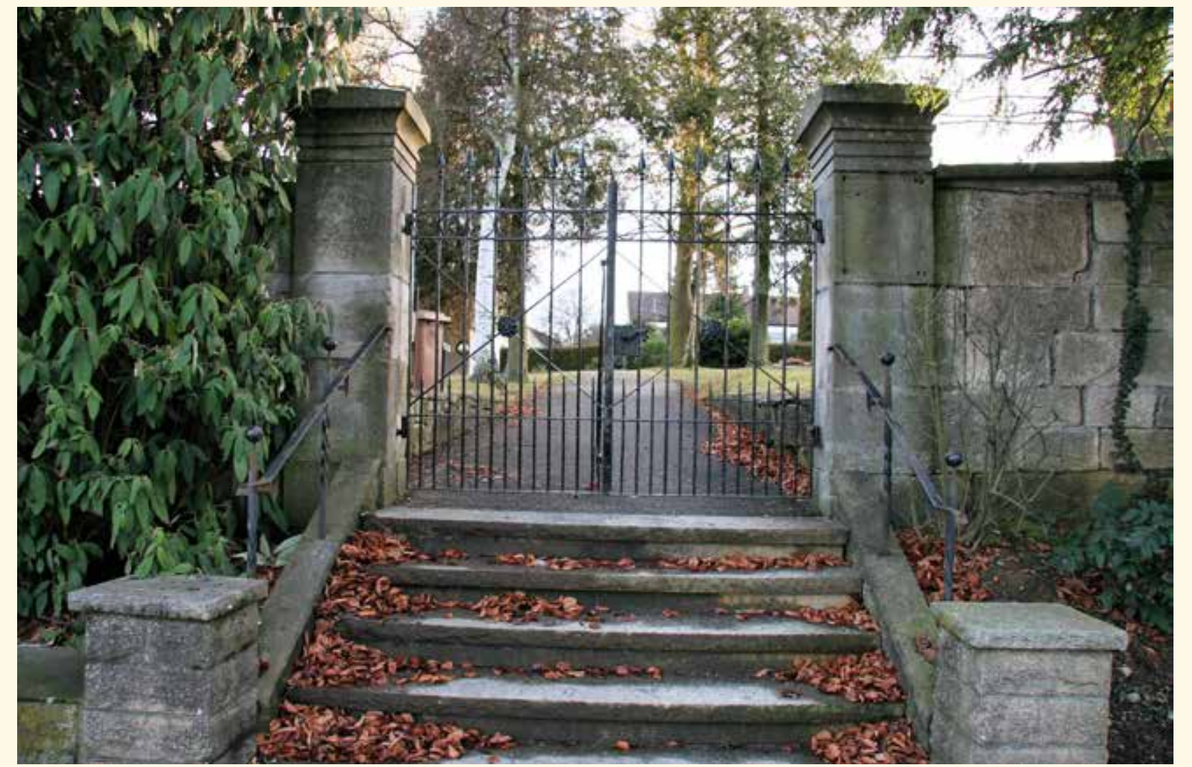
Haupteingang von der Weidacher Steige gesehen
